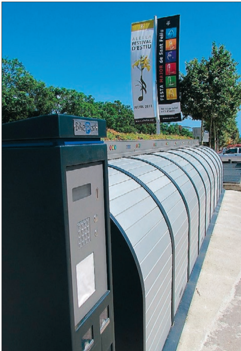
Sistema modular de aparcamiento de bicicletas en Alella.
